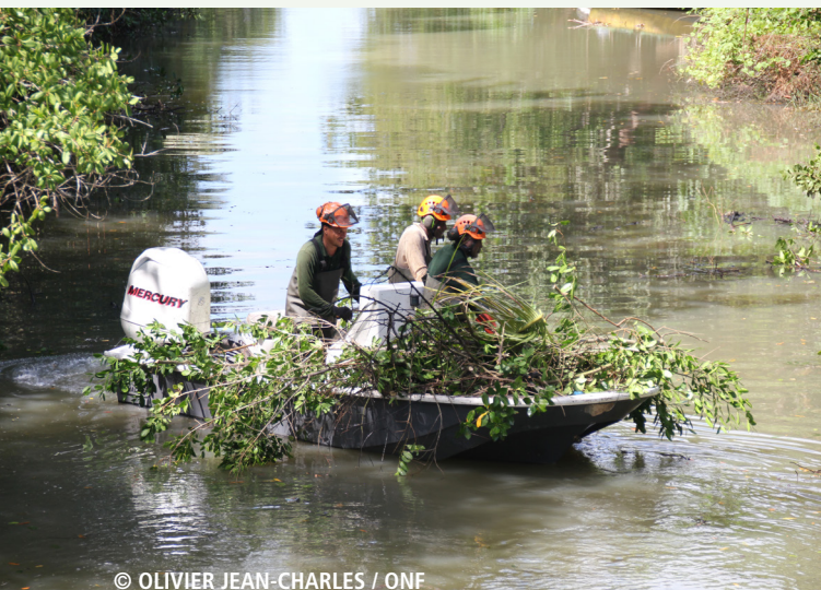
Travaux Canal des Rotours
