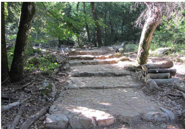
Chemin du Canapé après restauration
