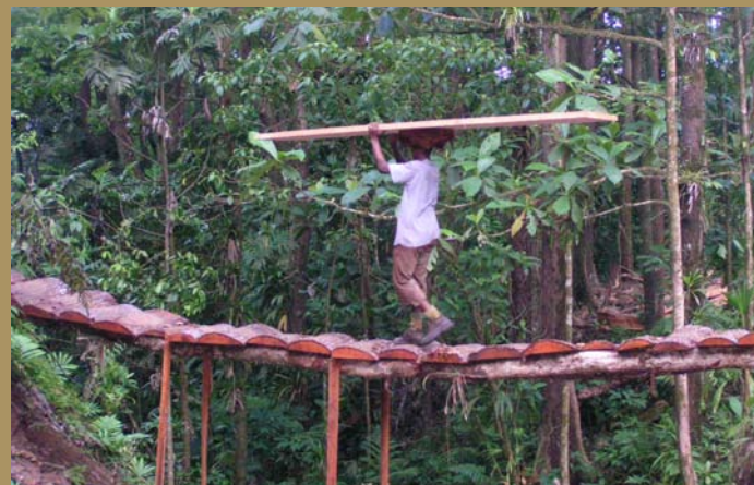
Les exploitants utilisent des déchets de coupe pour construire un chemin temporaire (ONF, 2007)
