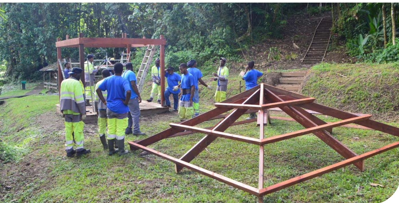
Figure 46 & 47 : Montage d'un carbet en bois par l'équipe d'insertion, encadré par l'atelier bois (ONF, 2017)
